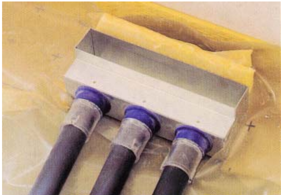
Abb. 3-3 Zuluflleitungen (Durchmesser 42/47 mm) und Durchlass
