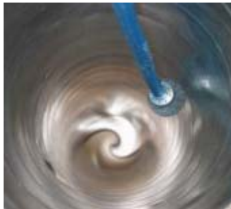
Abb. 4-5: Reinigung eines runden Querschnittes durch Bürsten
