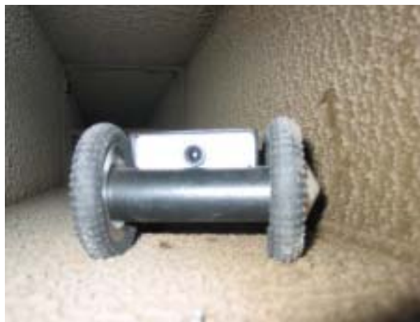
Abb. 4-2: Kameraroboter zur Inspektion von rechteckigen Lüftungskanälen
