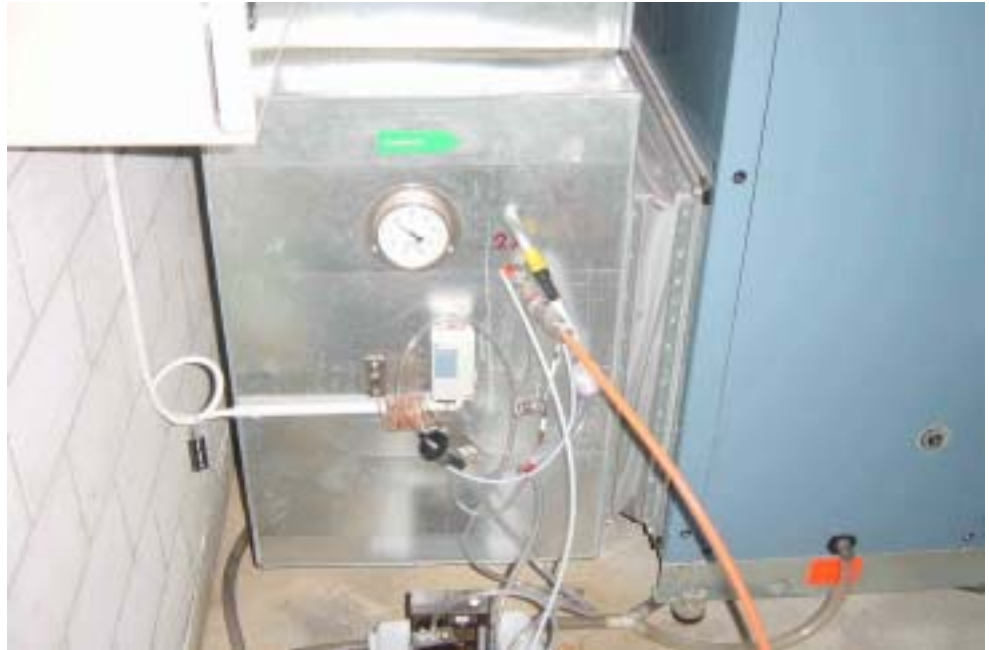
Abb. 5-6: Gebäude C, Messpunkt 1b, Aussenluft nach LER
